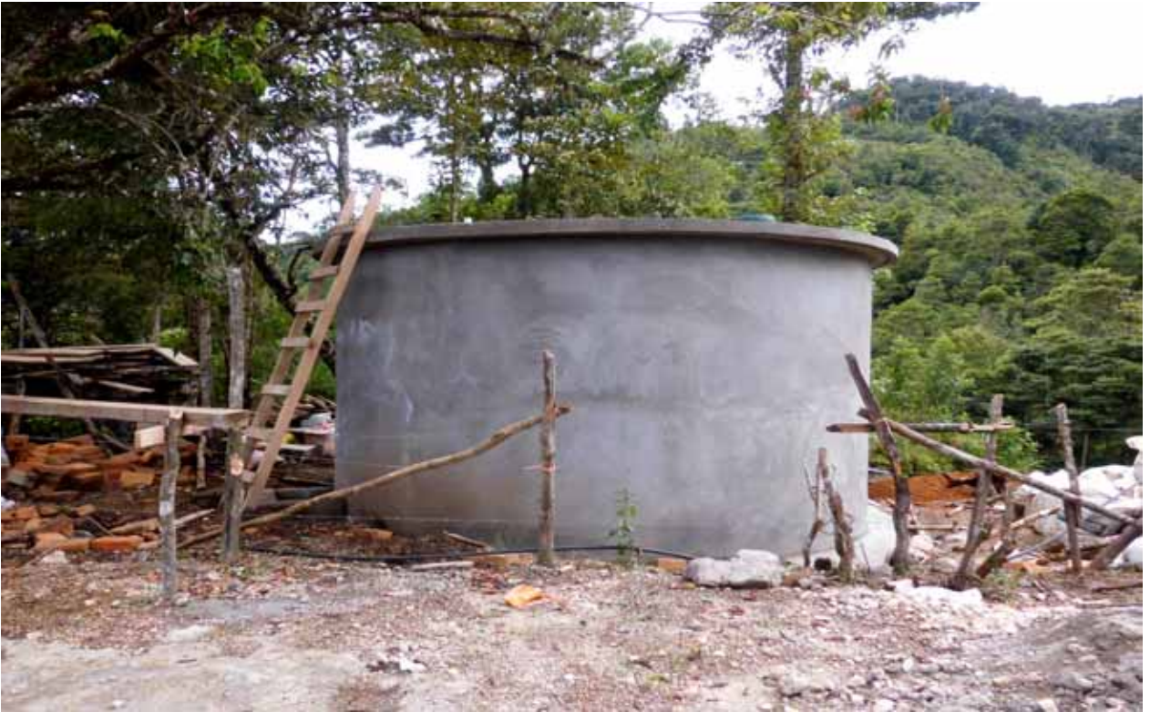
TANQUE DE ALMACENAMIENTO TERMINADO.
