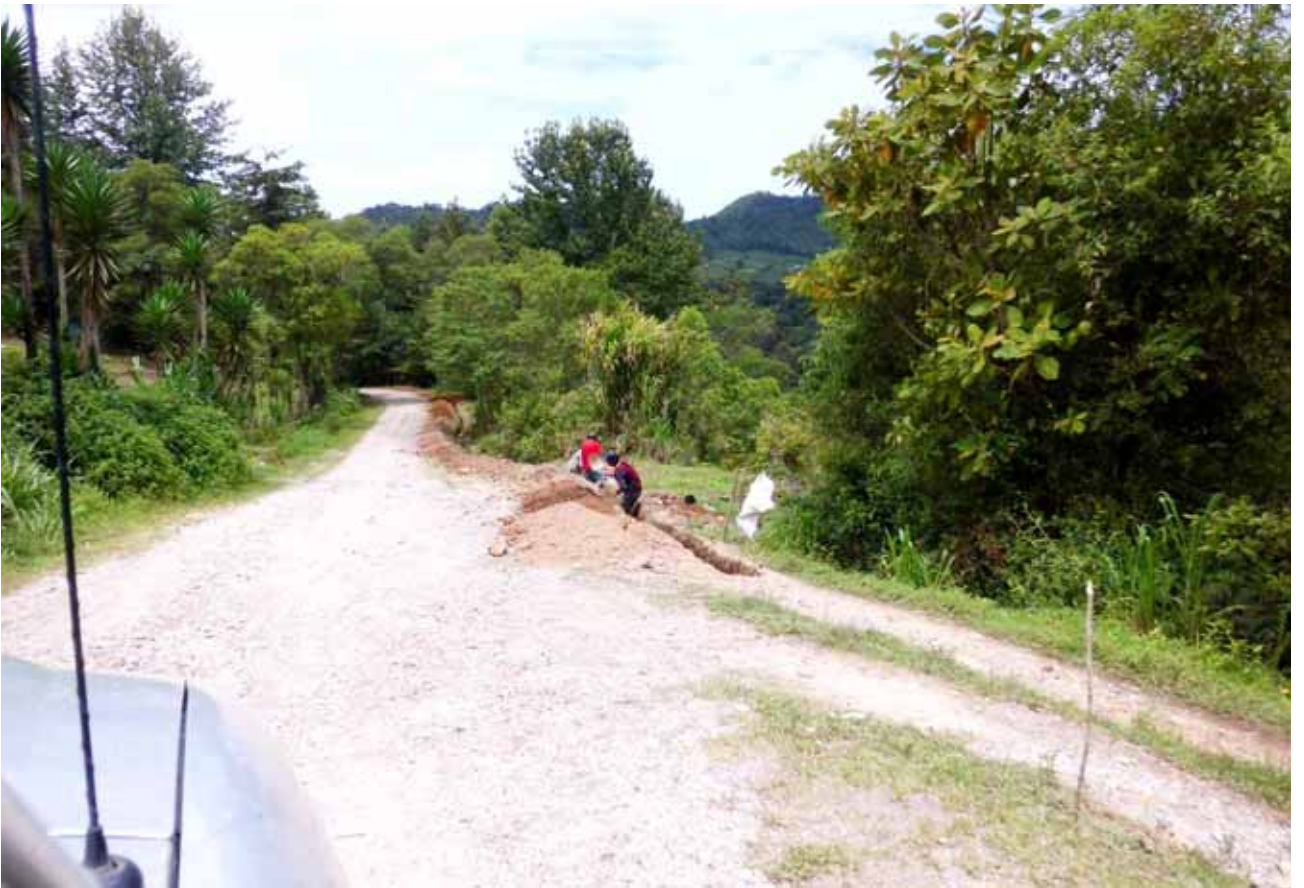
TRABAJANDO EN LA RED DE DISTRIBUCION.
