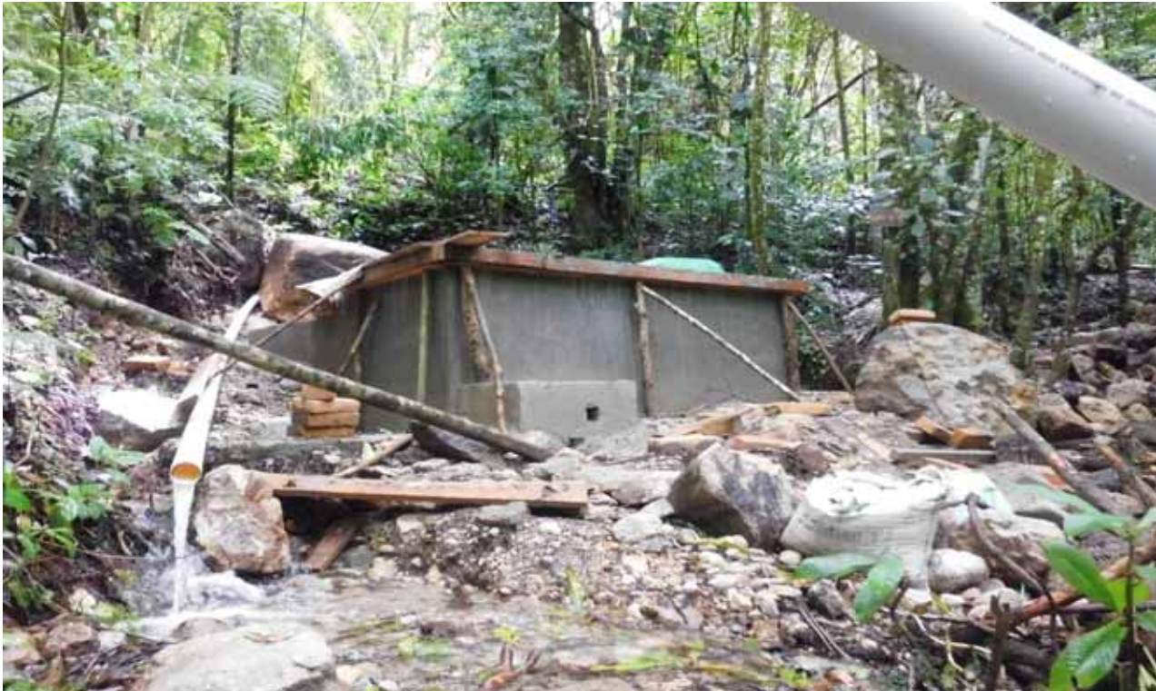
OBRA TOMA DE BELEN, MANAZAPA.
