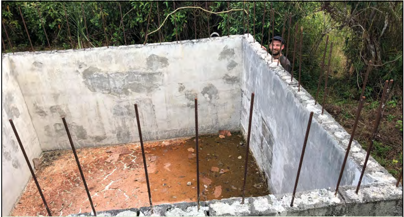
Bajo Algodón: WEFTA team at the unfinished tank site
